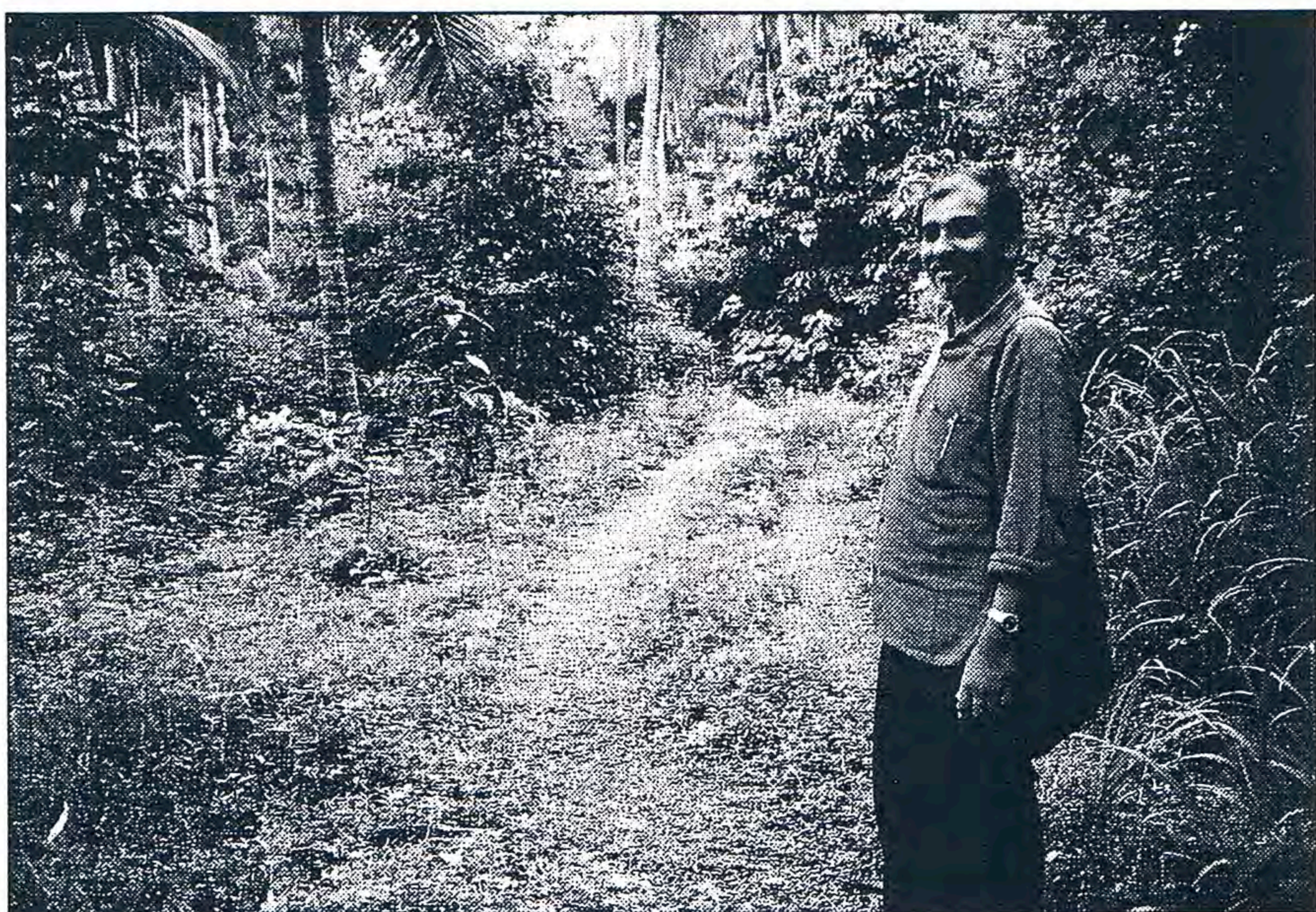
Pater George am Bauplatz der geplanten Unterkunft für die Verwandten der Patienten. Foto: Joas
